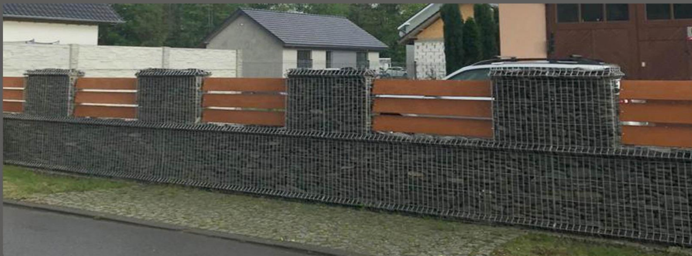
Fot. 3 Ogrodzenie gabionowe wypełnione łupkiem szarogłazowym
