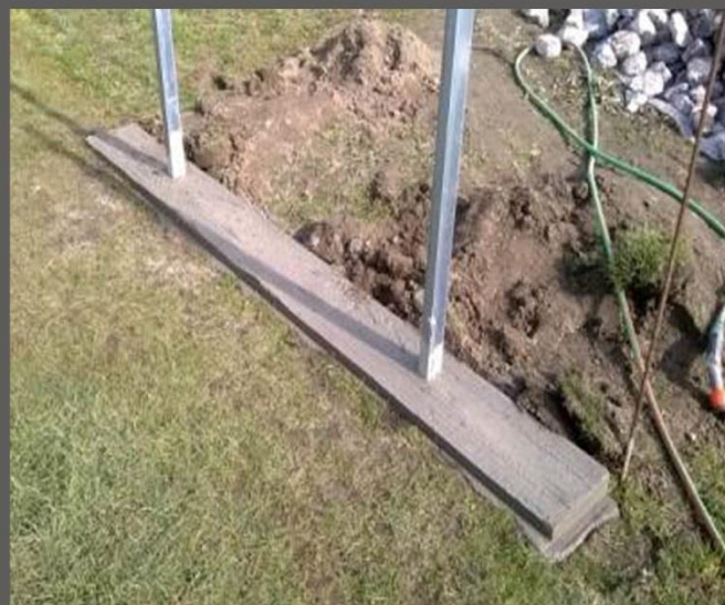
Fot.5 Wbetonowane słupy stabilizacyjne (Rafmet www.gabiony-panele.pl )
