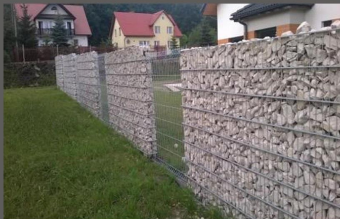
Fot. 2 i 3 Wykonanie gabionów bezpośrednio na podłożu (Rafmet www.gabiony-panele.pl )
