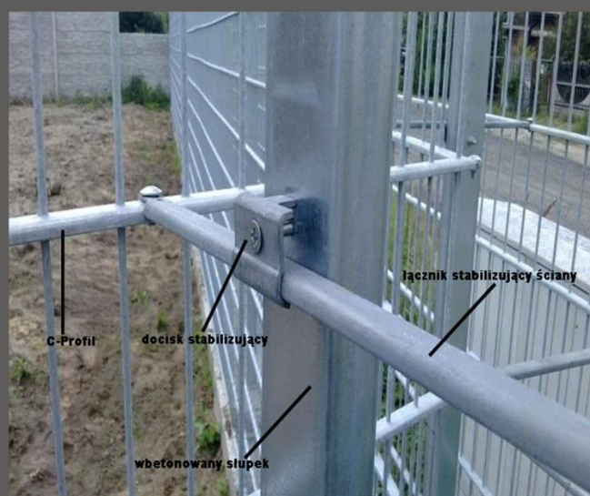
Fot. 15 i 16 Połączenie kosza gabionowego ze słupkiem (RAFMET www.gabiony-panele.pl )
