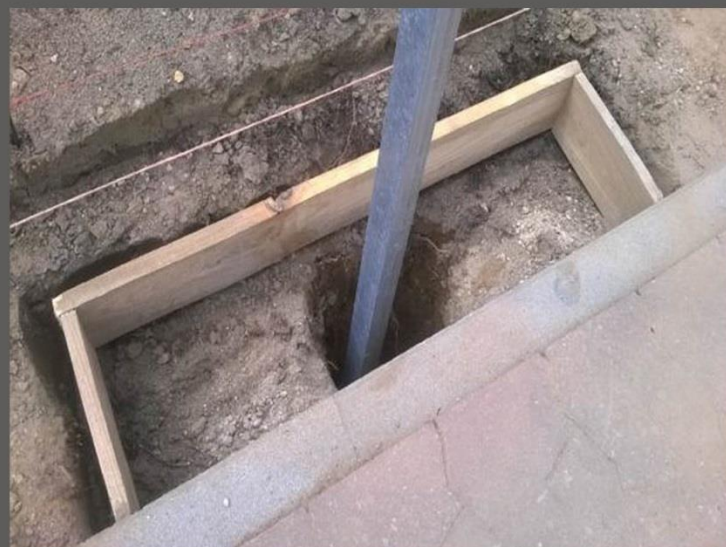
Fot.4 Pojedynczy słup stabilizacyjny przed zabetonowaniem (Rafmet www.gabiony-panele.pl )
