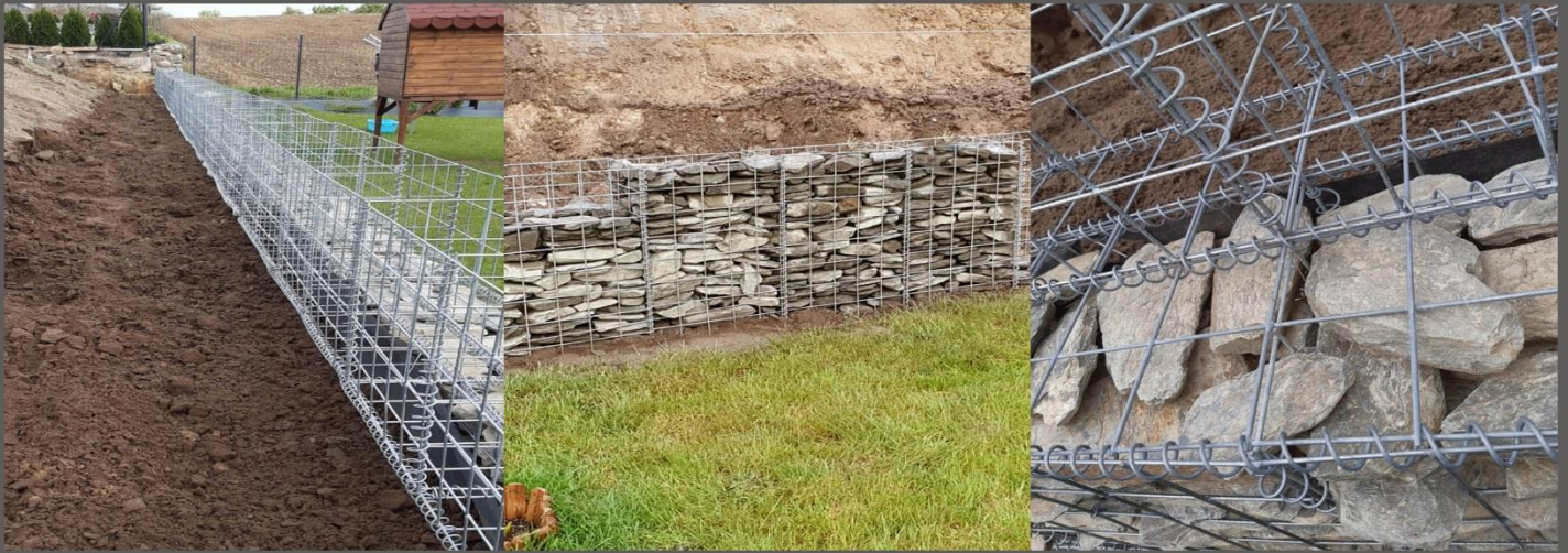
Fot. 9 Mur oporowy z koszy gabionowych wypełnionych łupkiem szarogłazowych
