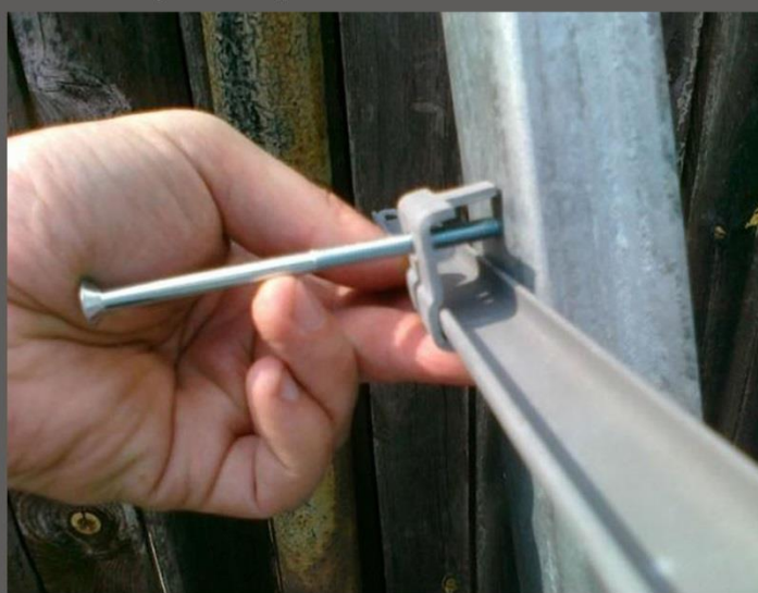
Fot. 15 i 16 Połączenie kosza gabionowego ze słupkiem (RAFMET www.gabiony-panele.pl )
