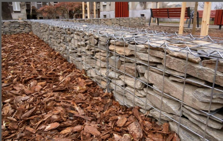
Fot.1 Murek gabionowych wypełniony łupkiem szarogłazowym.
