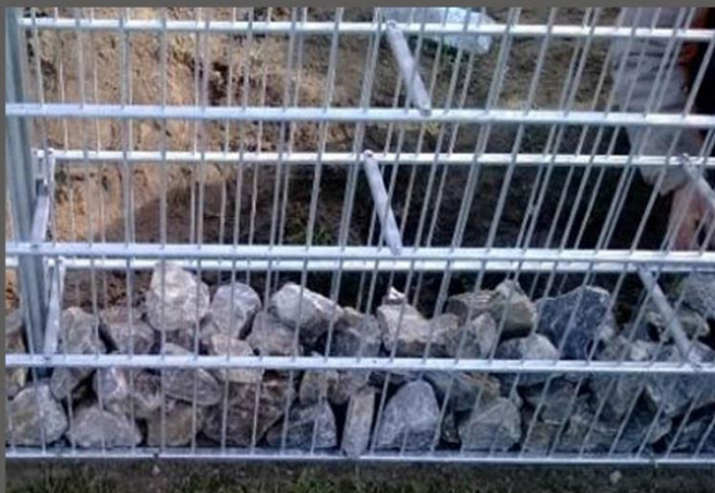
Fot. 11 Łączniki stabilizacyjne wewnątrz kosza gabionowego (RAFMET www.gabiony-panele.pl )
