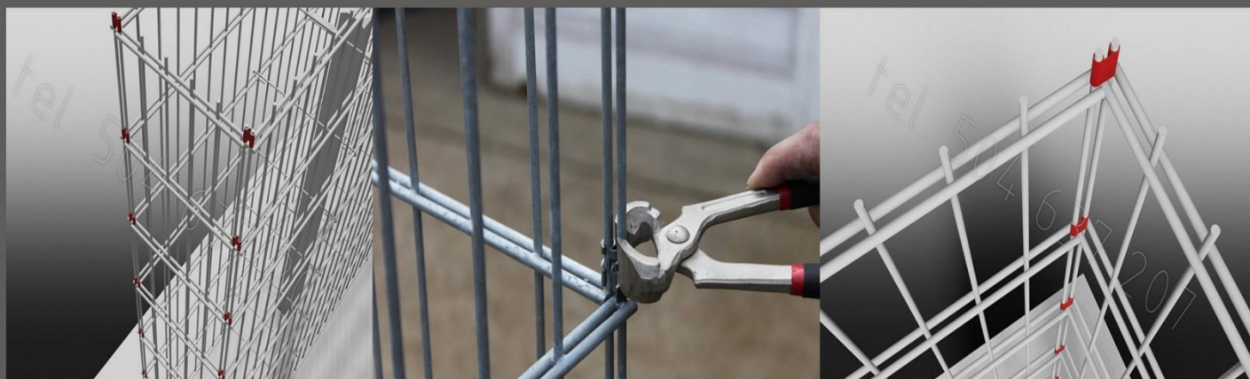
Fot. 7 Łączenie ścian gabionu (Producent gabionów HDTON ( www.ogrodzeniagabionowe.com ))
