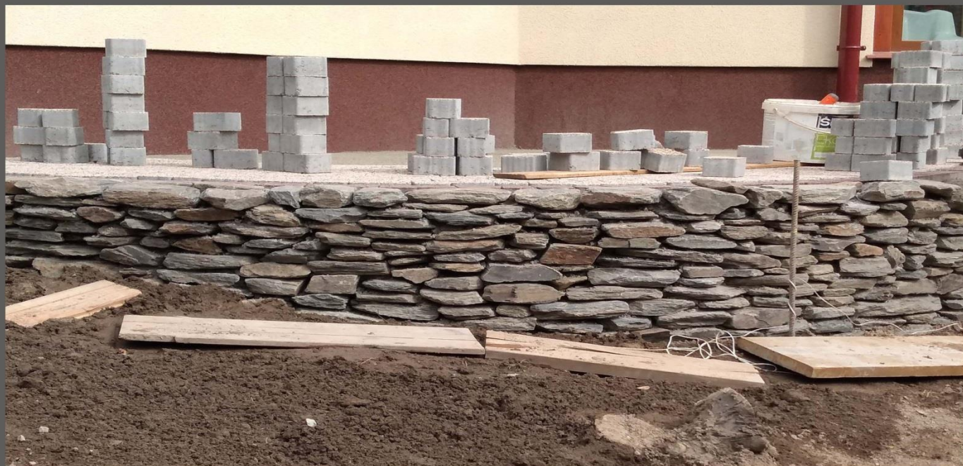
Fot.22 Oklejanie betonowego murka oporowego lupkiem gabionowym.
