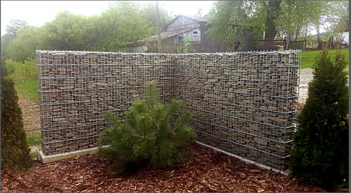
Fot. 20 Ogrodzenie gabionowe wypełnione łupkiem szarogłazowym
