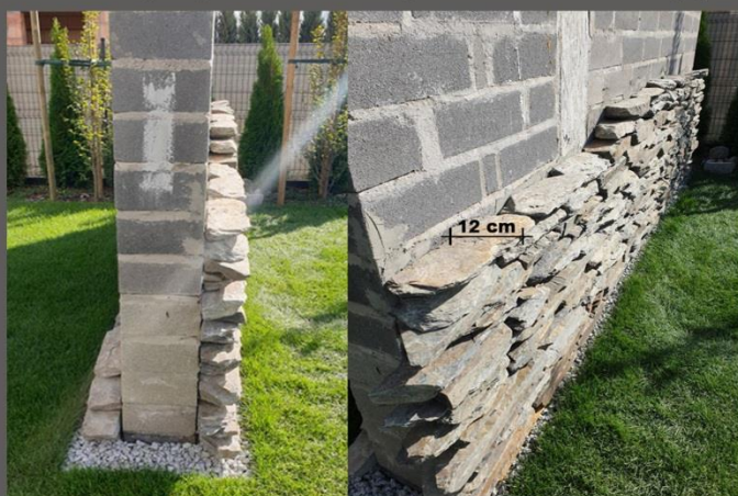
Oklejanie muru kamieniem jednostronnie ciętym „12cm”
