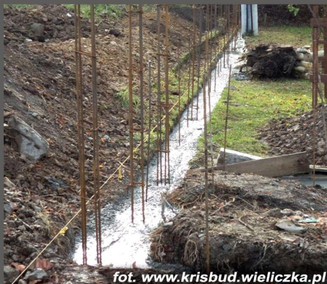
fot.9 Przykład pionowego zbrojenia przyszłego muru.
